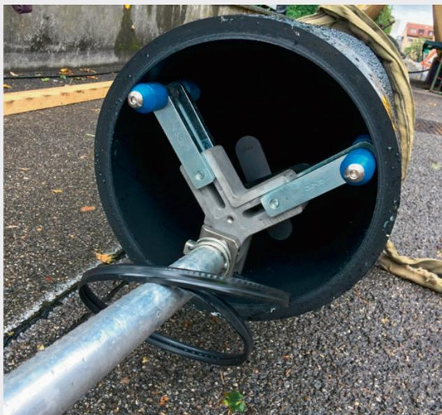
Fig. 8 Innen wie aussen werden beim PE-Rohr die Schweisswulste mit Spezialwerkzeug entfernt.
