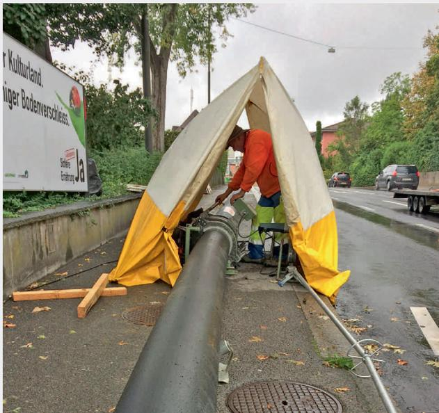
Fig. 2 Der vorgeschweisste Rohrstrang aus Polyethylen wird für den Einzug vorbereitet.
