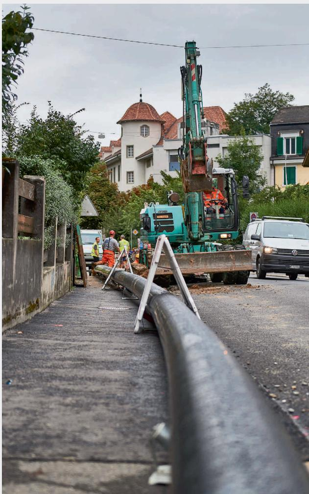
Fig. 3 Mittels Heizelementstumpfschweissen entsteht aus einzelnen Rohren ein langer Druckrohrstrang.
