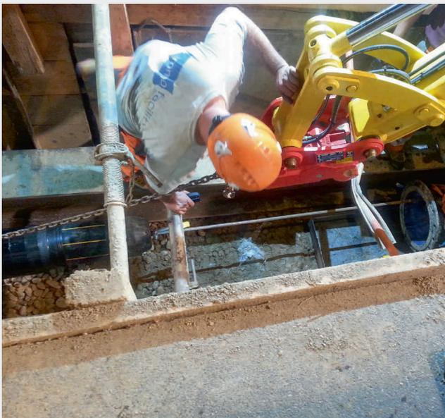
Fig. 7 Der Rohrstrang (links) hängt am Kabel der Zugmaschine für den Einzug ins Altrrohr (rechts).
